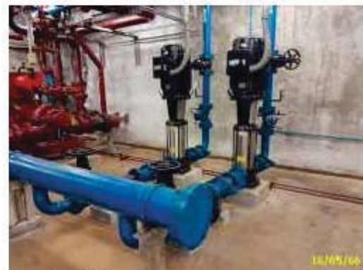
พื้นที่ถังเก็บน้ำใต้ดิน พร้อมเครื่องปั๊มน้ำ
